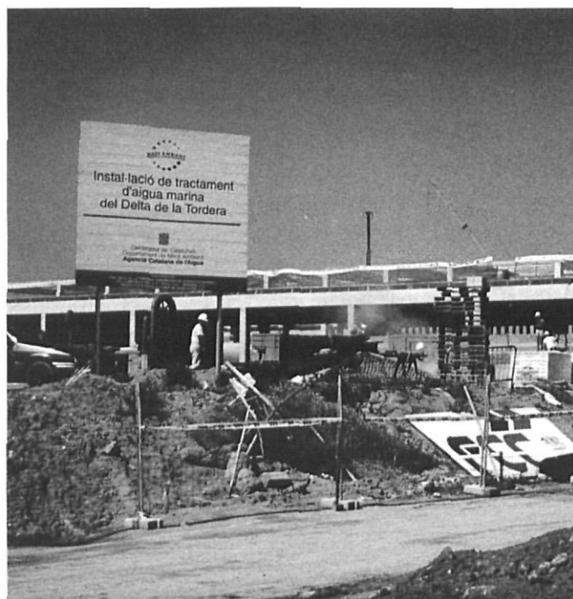
Construcció de la planta dessalinitzadora de la Tordera (Blanes), la primera de tot Catalunya.
