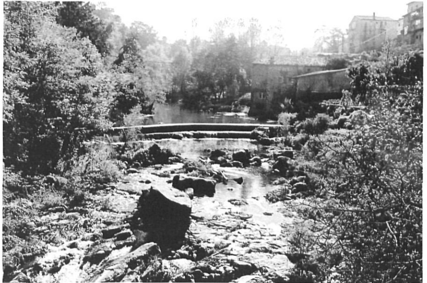
Des del pont de Can Poxas. El molí d'en Daina.
