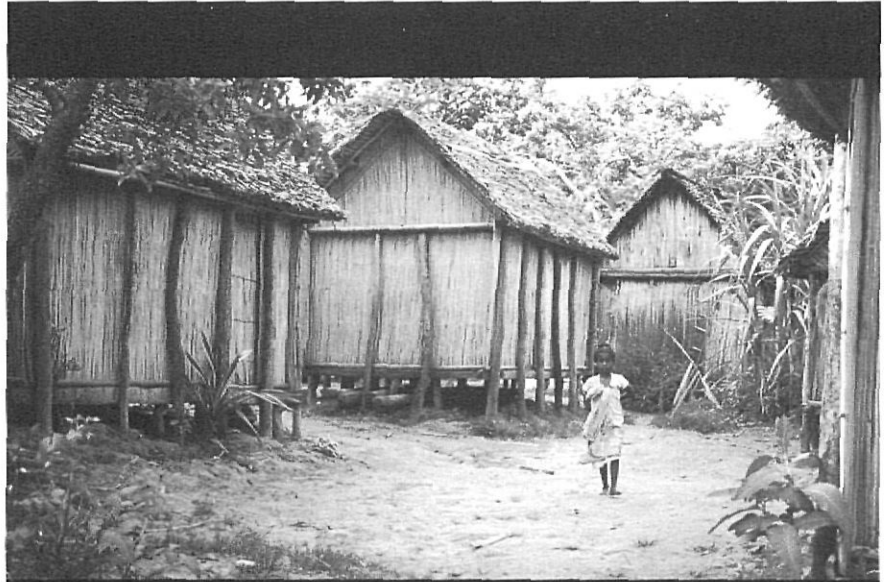
Cases d'un poblet de l'illa de Sainte Marie, construïdes amb fusta i branques de palmera.
