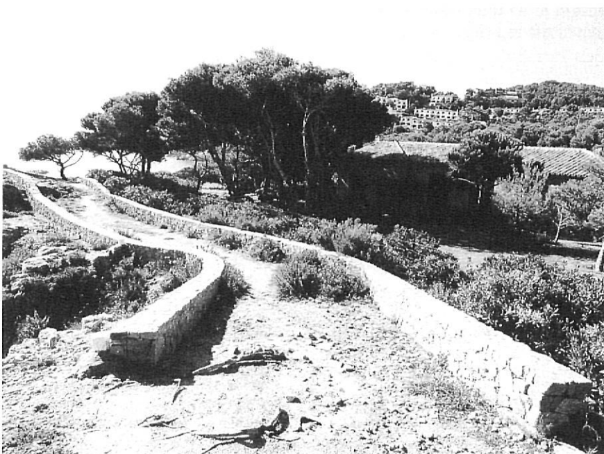
El paratge de la Roncadora, a Aigua-xel·lida, té un camí de ronda construït i cedit per la generositat d'un propietari. Tot un model que cal agrair.
