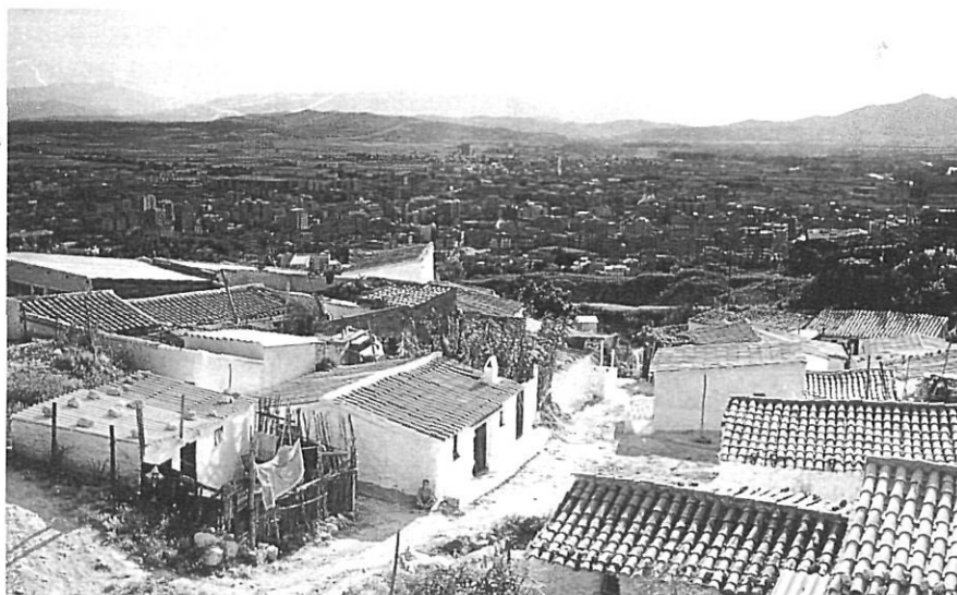
Les barraques de les Pedreres de Girona, l'any 1967.
