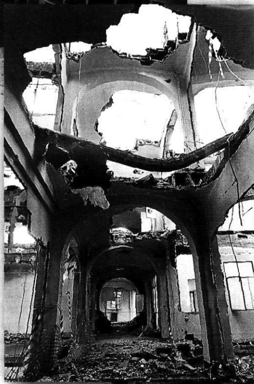
L'edifici sindical, el setembre de 1992.
