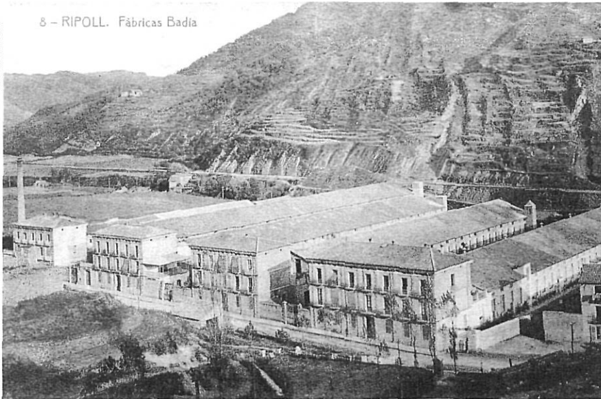
La construcció de les fàbriques tèxtils Badia, el 1894, comportà l'expansió de la xarxa elèctrica vers la carretera de Sant Joan.
