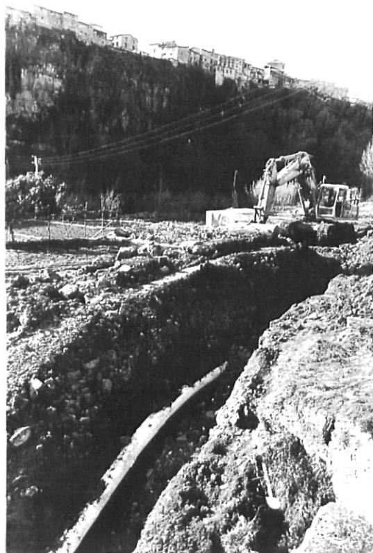
Treballs de conducció del gas a Castellfollit i altres indrets de la Garrotxa.
