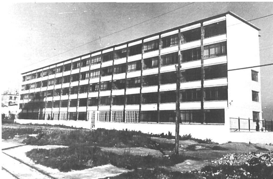
L'edifici en construcció de la "nova" Normal.
