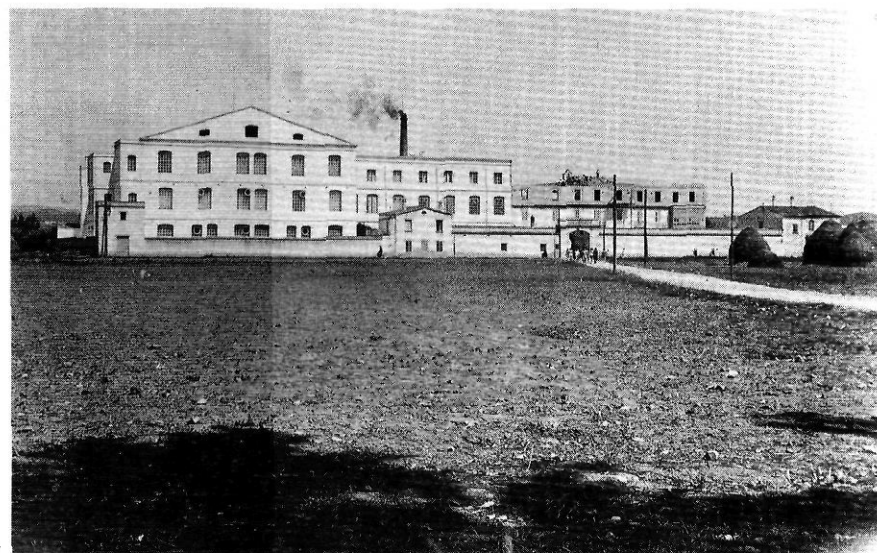
Façana de la fàbrica Coma i Cros (1915-1922). Obres d'ampliació de la fàbrica.
