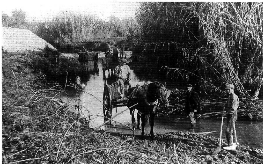
Inici dels treballs per a les obres de sobrelevació i modificació del traçat de la sèquia Monar (1915-1924).
