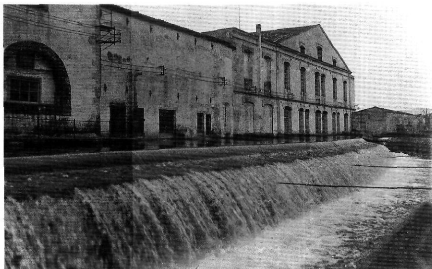
Façana posterior de la fàbrica Coma i Cros i de la sèquia Monar (1910-1915), abans de l'inici de les obres d'ampliació. En primer terme hi ha el salt d'aigua que la sèquia té quan passa per darrera la fàbrica.
