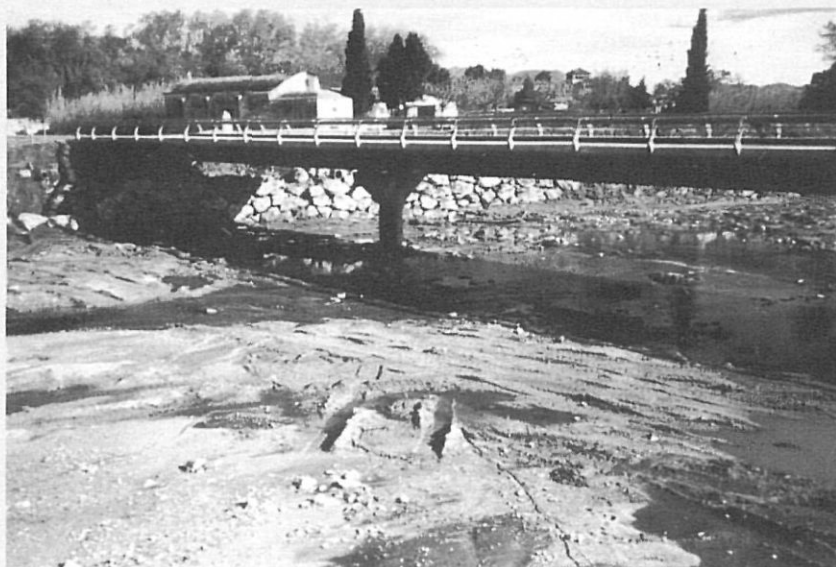
Pont nou sobre el riu Llobregat (Peralada) acabat el 10 de novembre de 1991.
