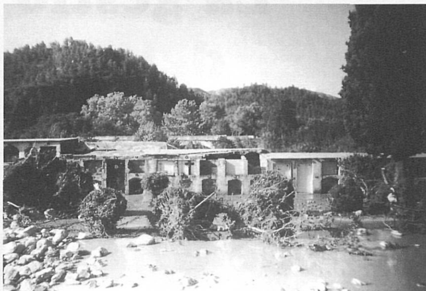
Cementiri de Sant Llorenç de la Muga. Crescoda de la Muga del 26-09-1992. Els efectes devastadors del riu van «rebotar» el cementiri.
