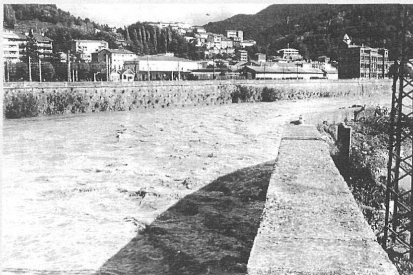
Ripoll. Canalització del Ter. Detall.
