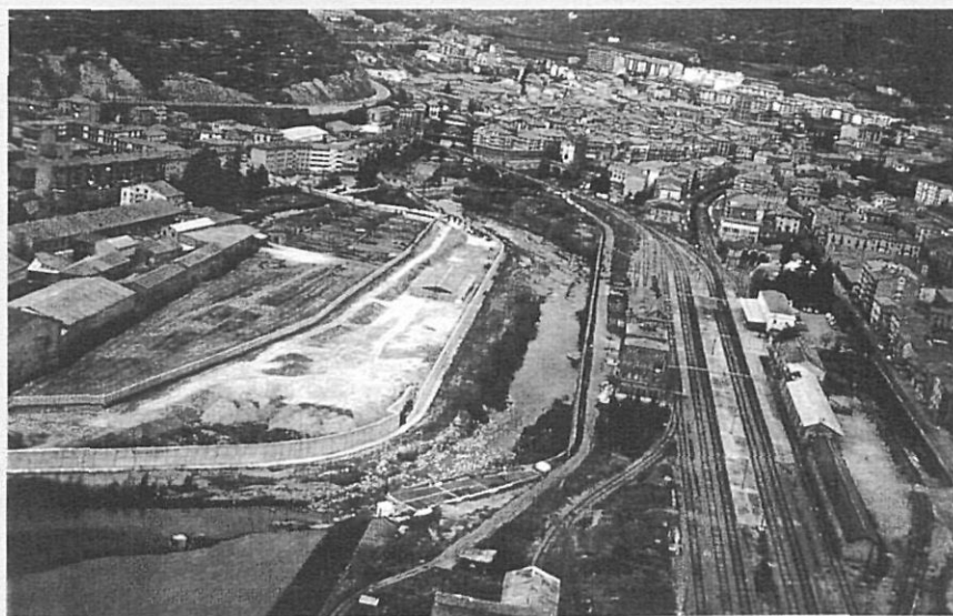
Ripoll. Canalització del Ter. Vista general.
