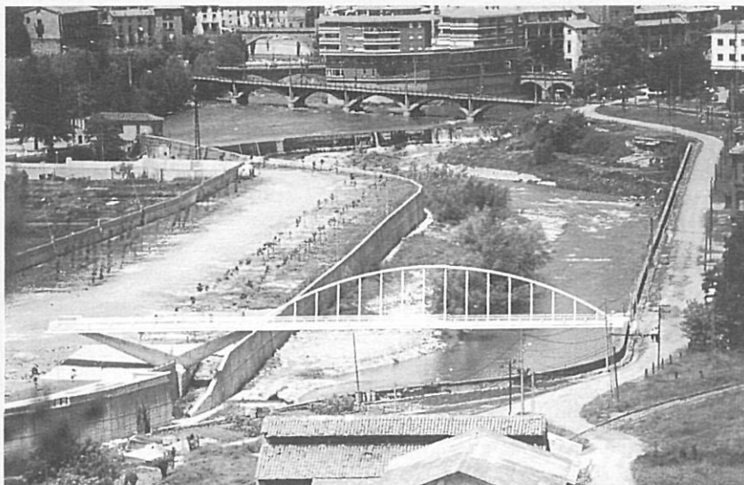
Ripoll. El pont de Calatrava sobre el Ter.
