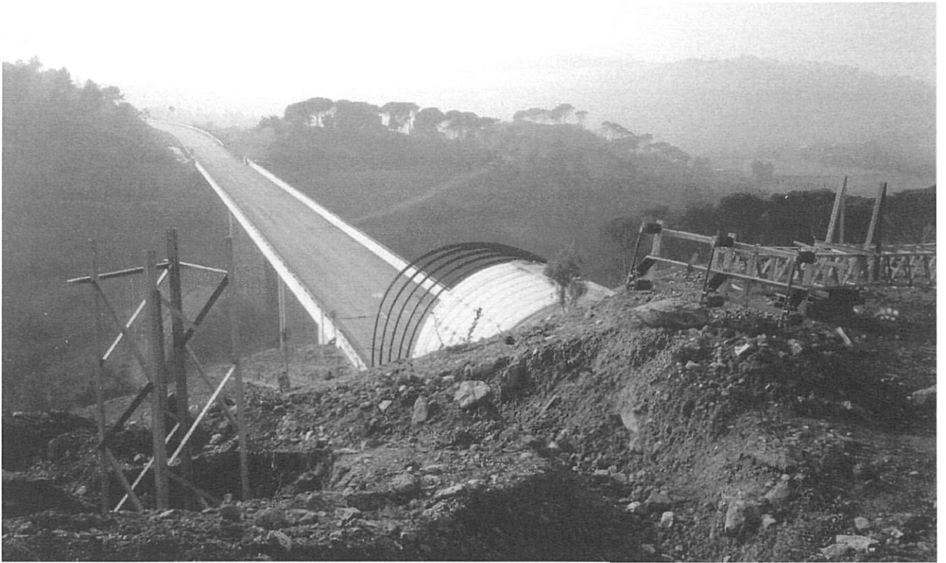
Variant N-II. Pont i túnel artificial de can Xifreu. Adéu-siau, torrents manyacs de Prudenci Bertrana.
