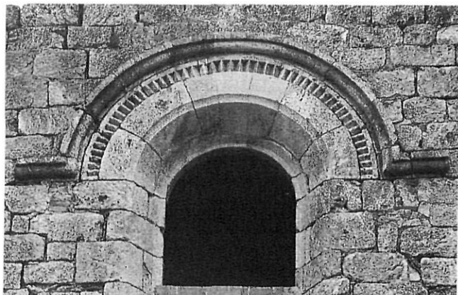
Detall de la decoració del gran finestral del frontis amb guardapols motllurat i arquivolta de dents de serra.
