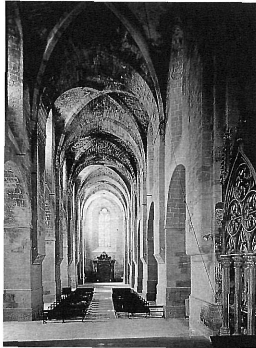
La volta de creueria de la nau central de Santes Creus, amb arcs sobre permòdols.
