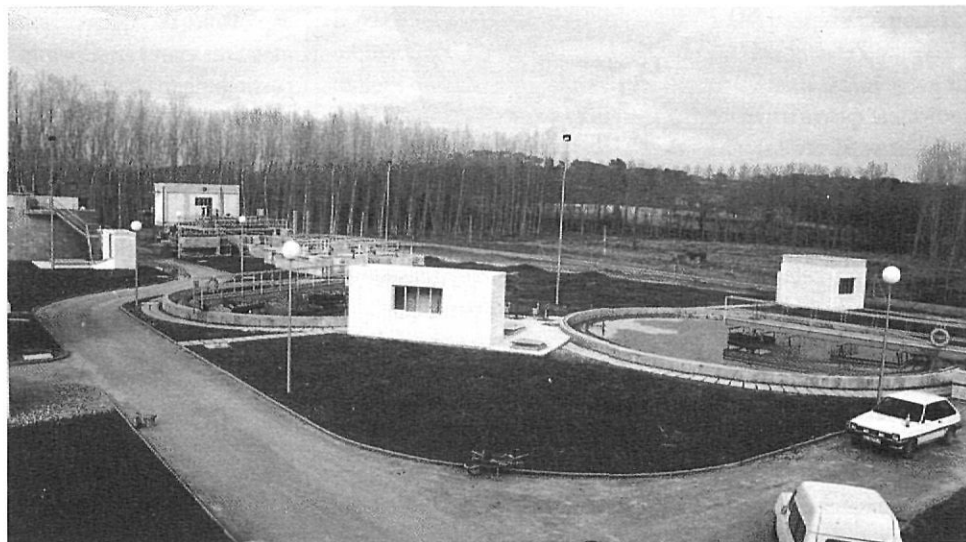
Vista parcial de la depuradora físico-química de Cornellà de Terri, que té com a missió el sanejament del riu Terri, un dels més contaminats de Catalunya.
