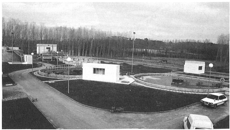
Vista parcial de la depuradora físico-química de Cornellà de Terri, que té com a missió el sanejament del riu Terri, un dels més contaminats de Catalunya.
