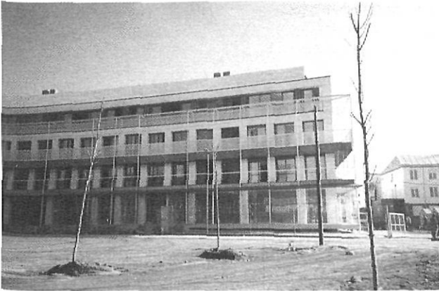
Illa núm. 1, obra dels arquitectes Cervera i Alonso
