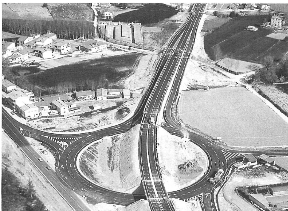
Enllaç Sud amb rotonda (Porqueres)
