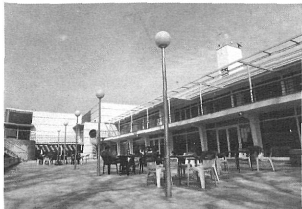
Vista parcial del complex del Club Natació Banyoles.
