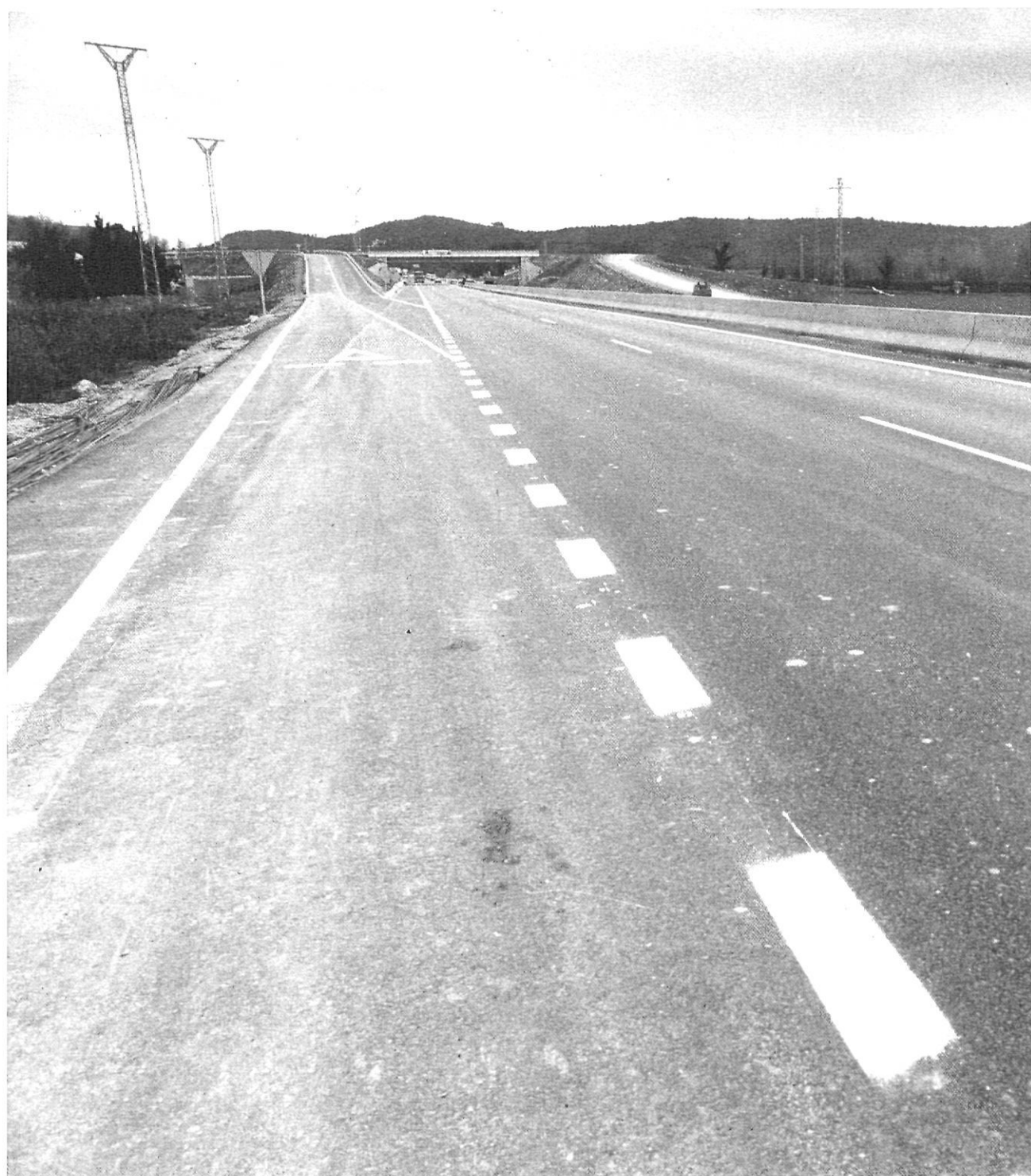
Vista panoràmica del desdoblament de la cc 150 a l'alçada de la recta de la Banyeta.
