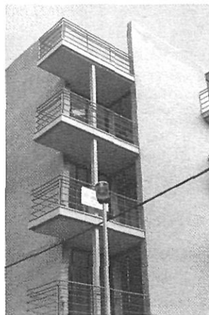
"L'illa núm. 9 juga amb una galeria volada a les cantonades"
