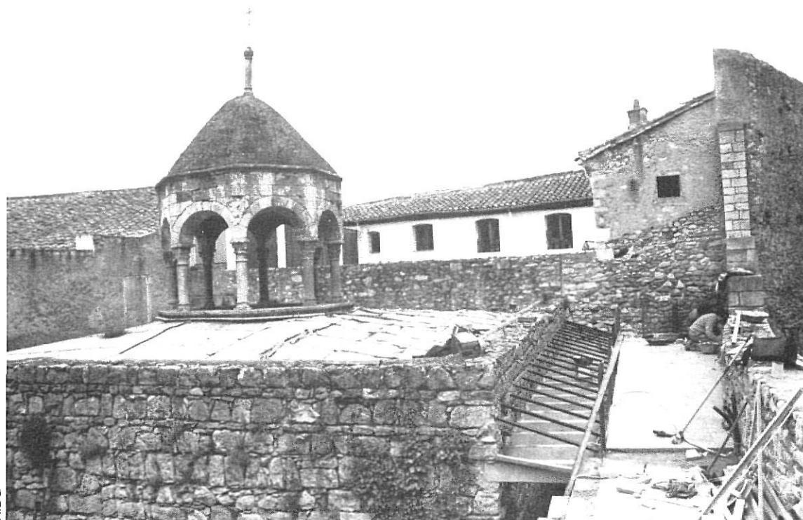
Rehabilitació dels Banys Àrabs: coberta del frigidari.
