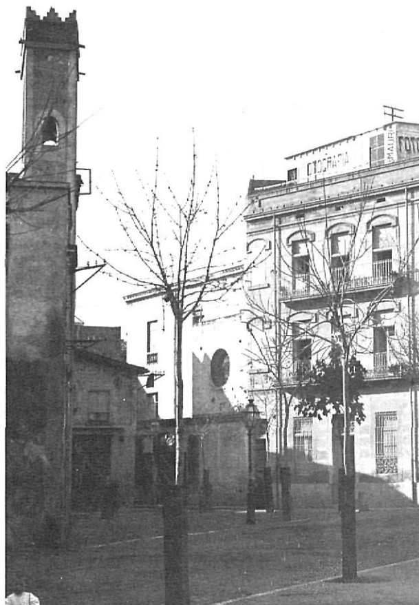
La galeria fotogràfica de Jesús Mauri situada en el terrat de la casa número 2 del carrer de l'Hospital, cantonada al carrer del May.
