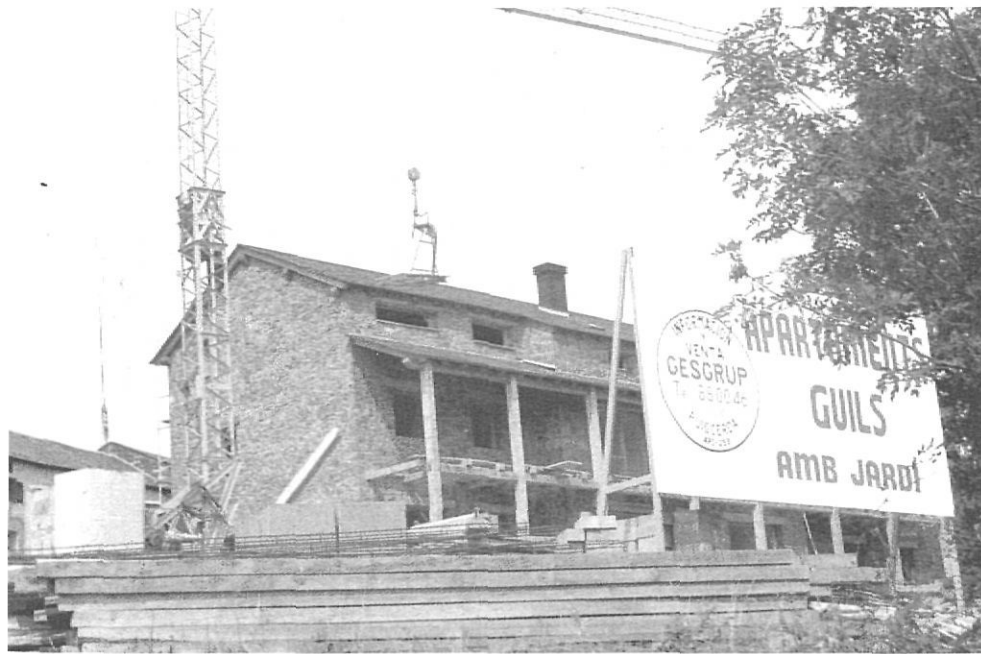
Apartaments en construcció a Guils de Cerdanya.
