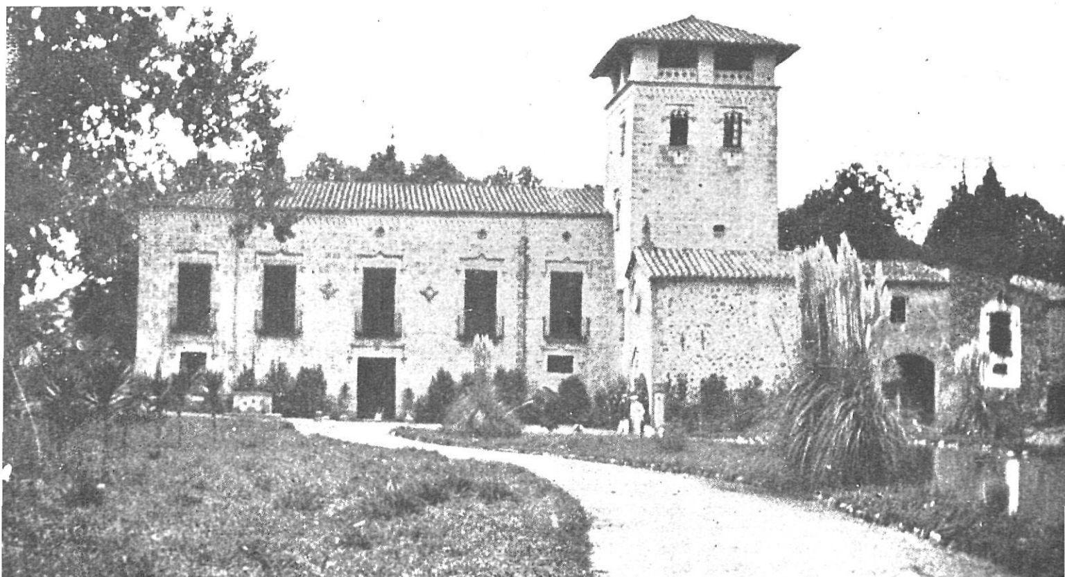
El mas Ribot a la primera dècada d'aquest segle. Residència del marquès de Camps, fou restaurat per l'arquitecte Francesc d'A. Garcia i Corrons (1844-1882).
