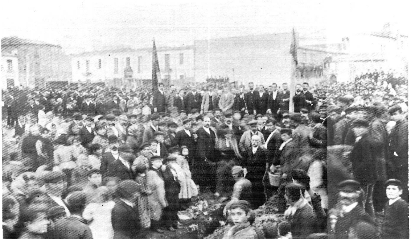
Un altre aspecte de la festa de l'acte de col·locació de la primera pedra.
