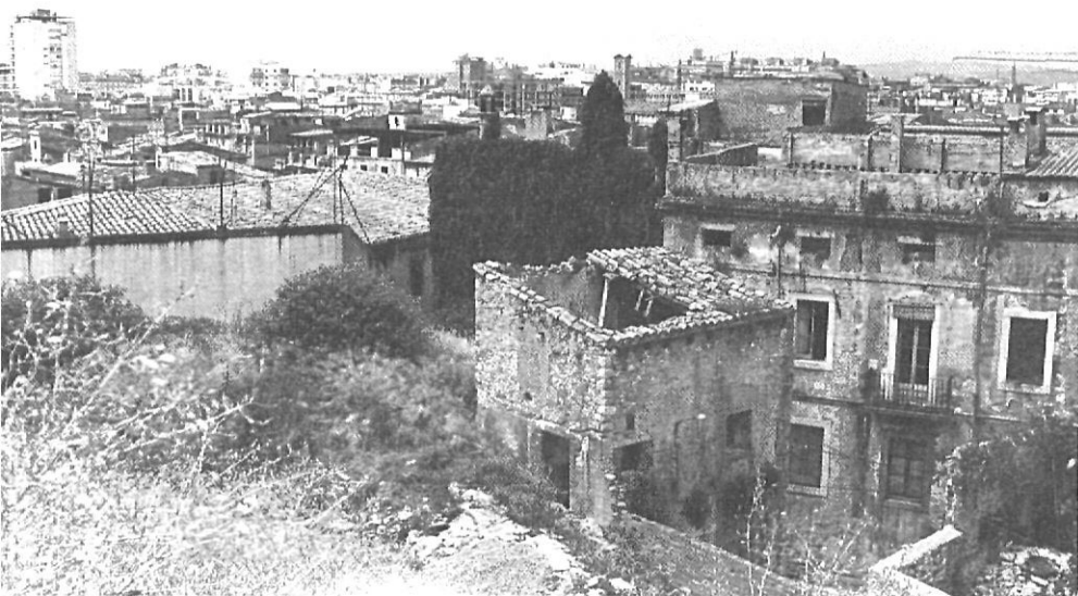
Les construccions annexes als Maristes que no van ser enderrocades i que donen al carrer del doctor Oliva i Prat han de ser estudiades amb cura, segons els arqueòlegs. Ara es troben en molt mal estat.
