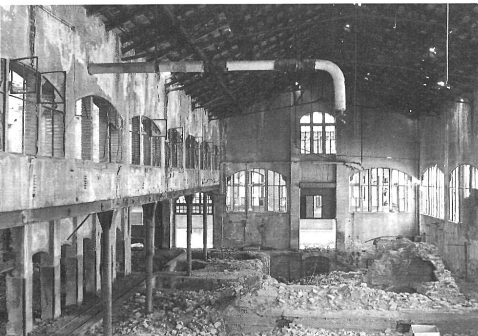
Aspecte actual de l'interior de la nau de les calderes i dels forns.
