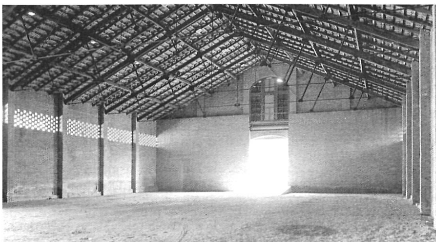
Interior d'un dels magatzems, on s'aprecien les encavallades de la coberta i el mur calat de la façana.
