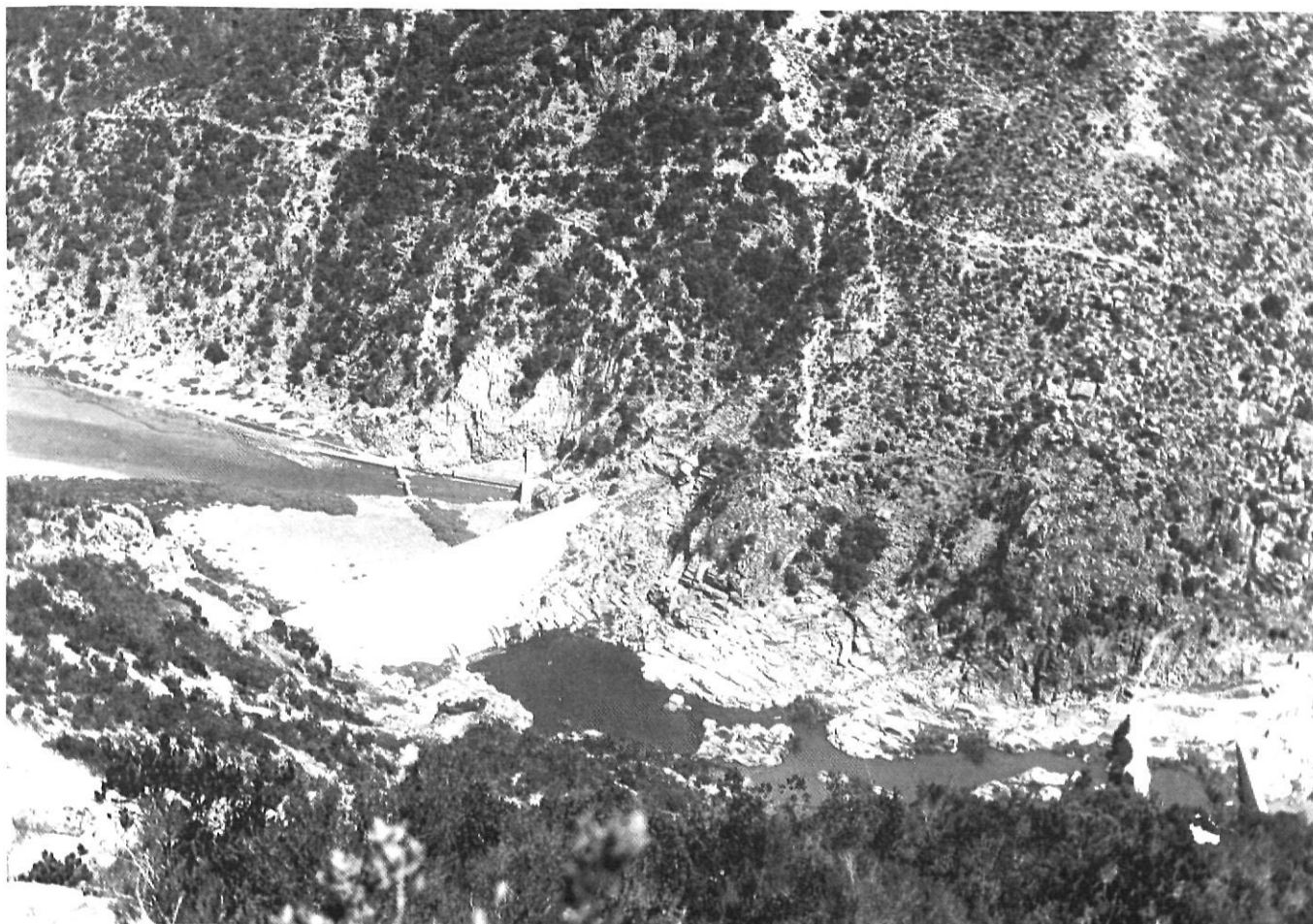
El pantà de Sau es va construir el 1962, amb un mur de 75 m. d'altura.
