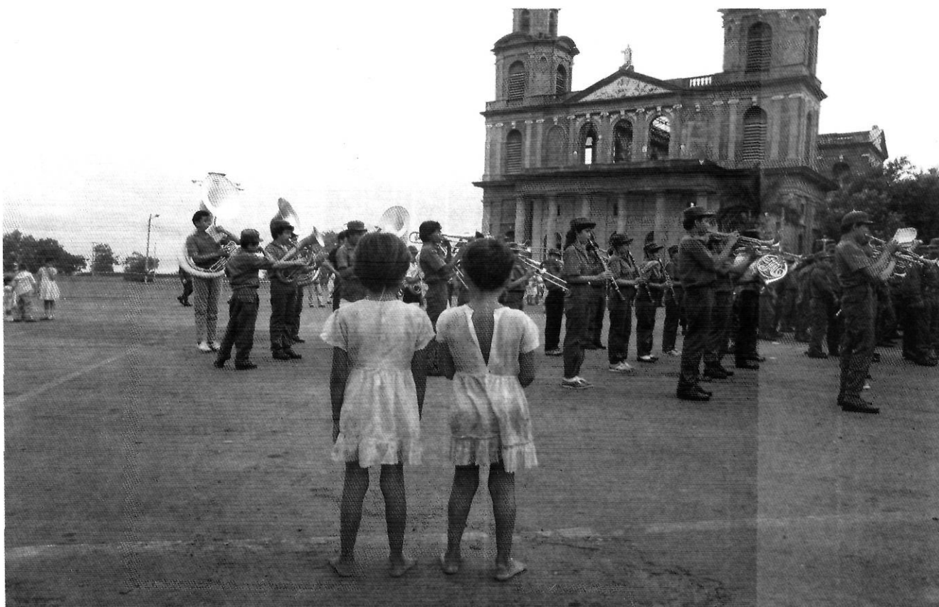
La banda toca en la commemoració dels bombers davant la catedral metropolitana, un edifici mig derruït que remet a èpoques pretèrites.
