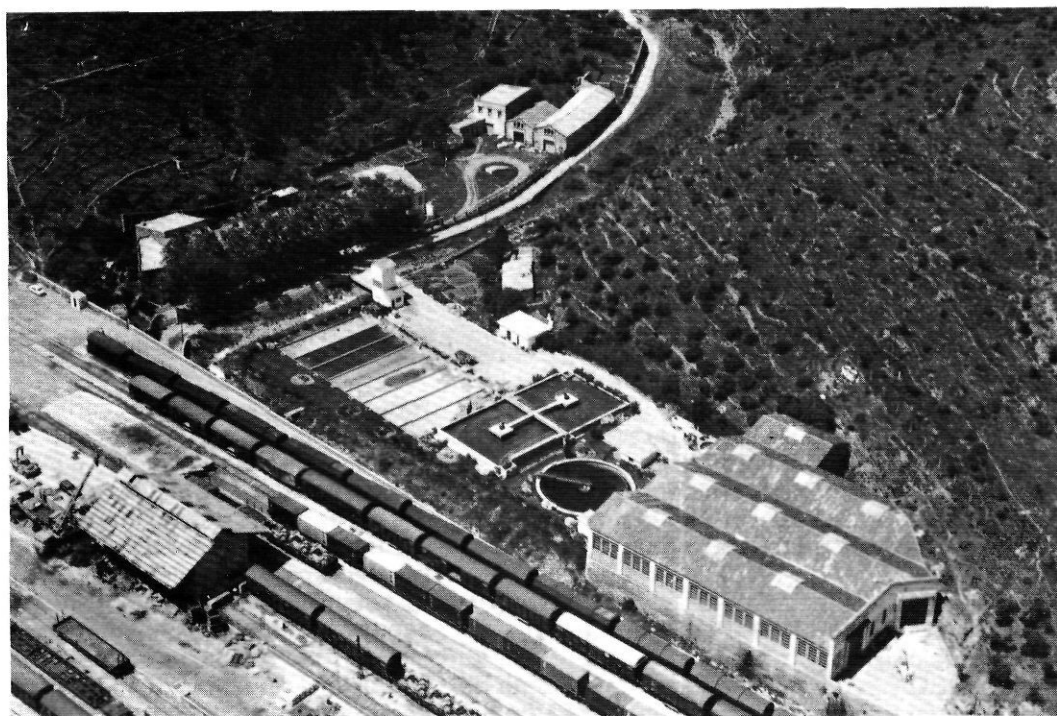
Instal·lacions depuradores de Portbou.
