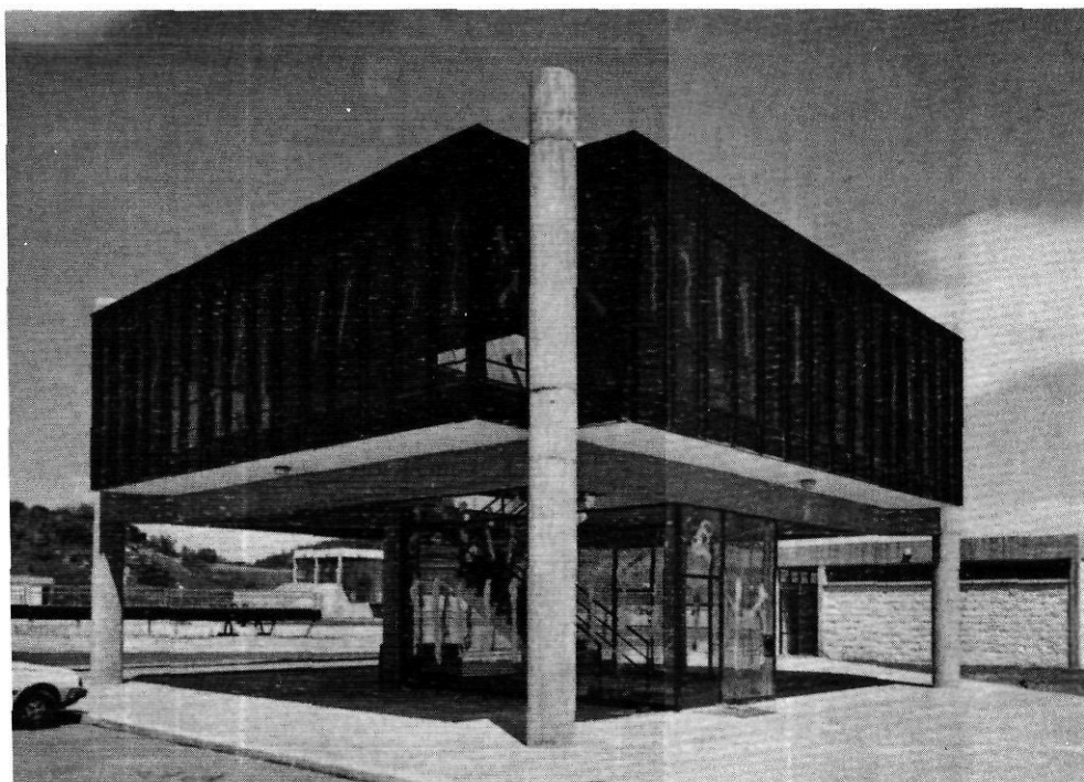
Edifici de control
