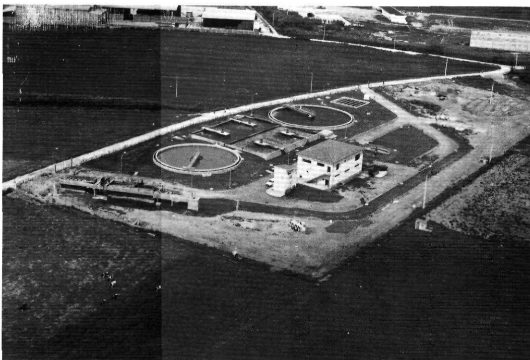
La depuradora de Colera, a dalt, i decantadors i reactors (Figueres).
