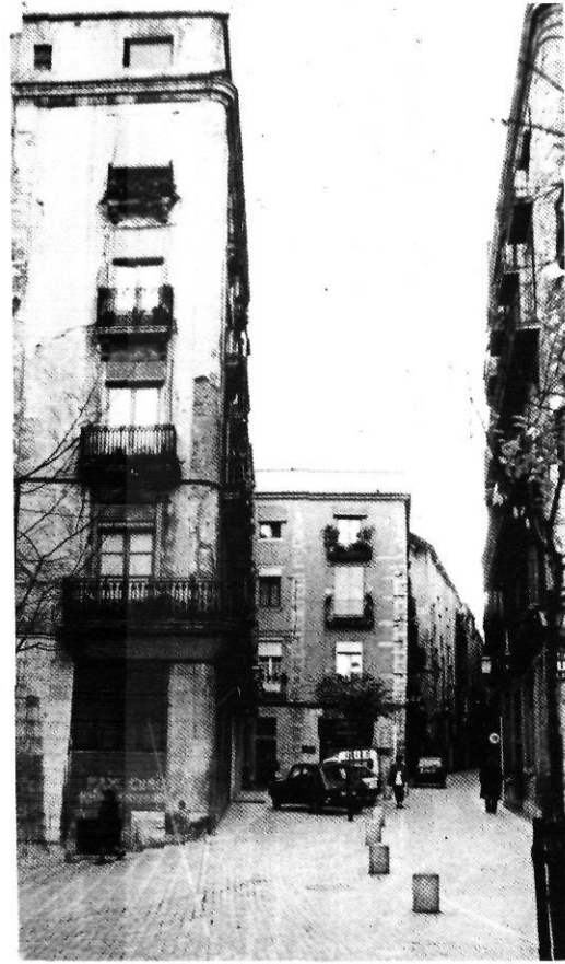
Carrer de la Força: culminació de les obres.
