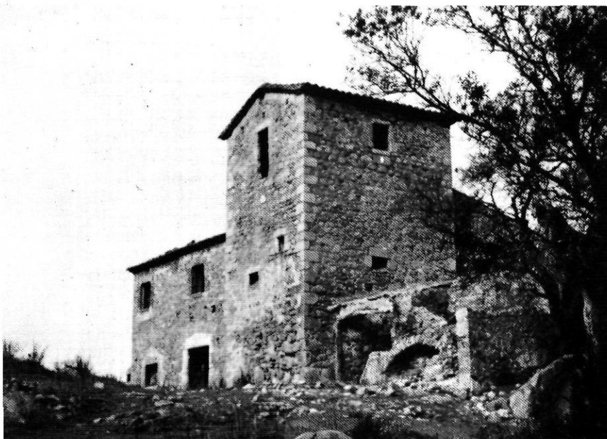
Torre de mas Pepó, Palamós. L'estat del conjunt és força ruïnós.
