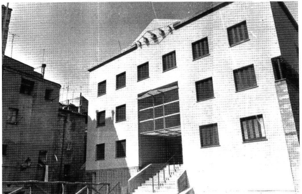
Un immoble difícilment compatible amb l'entorn urbanístic.
