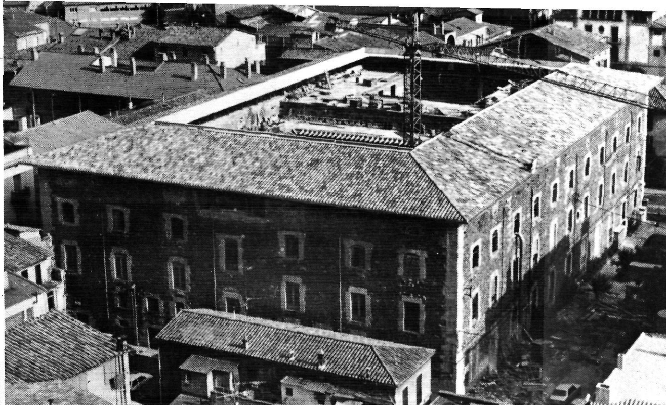
Vista general de l'antic Hospici d'Olot durant les obres de restauració.
