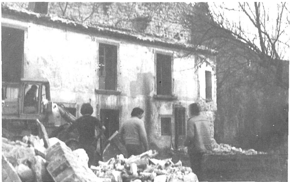
L'antiga casa de les Beates, en el moment de la demolició.
