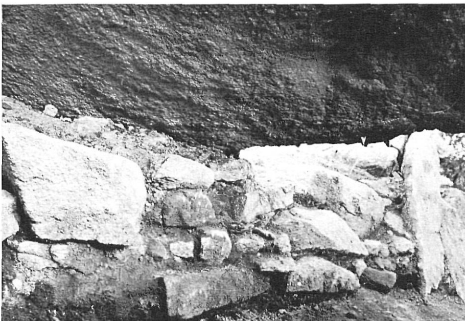
Làm. IV. - Detall de les filades de paret seca, de la banda dreta del corredor, sota la llosa de coberta estintolada al seu costat.
