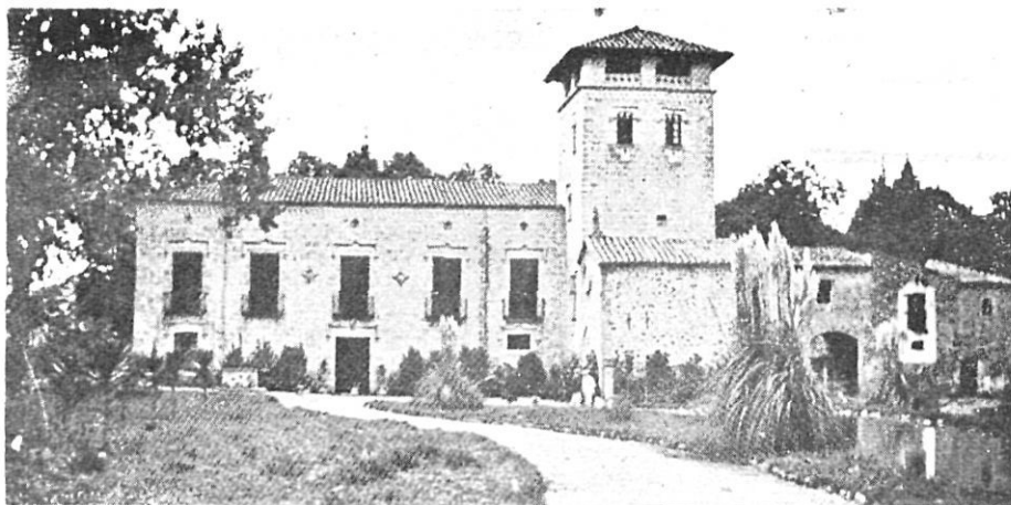
El mas Ribot a la primera dècada del segle XX. Residència del marquès de Camps, fou restaurat per l'arquitecte Francesc d'A. Garcia i Corrons (1844-1882), el qual projectà també l'oratori particu'ar de Pelai de Camps (1828-1889), primer marquès de Camps segons concessió pontificia del 1878.
