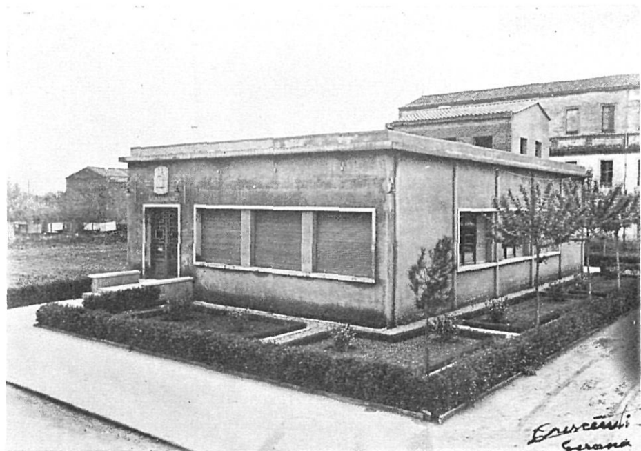
Nou ajuntament de la vila, inaugurat el 25 de juliol de 1943. L'edifici havia estat construït per la CNT durant el període bèl·lic.
