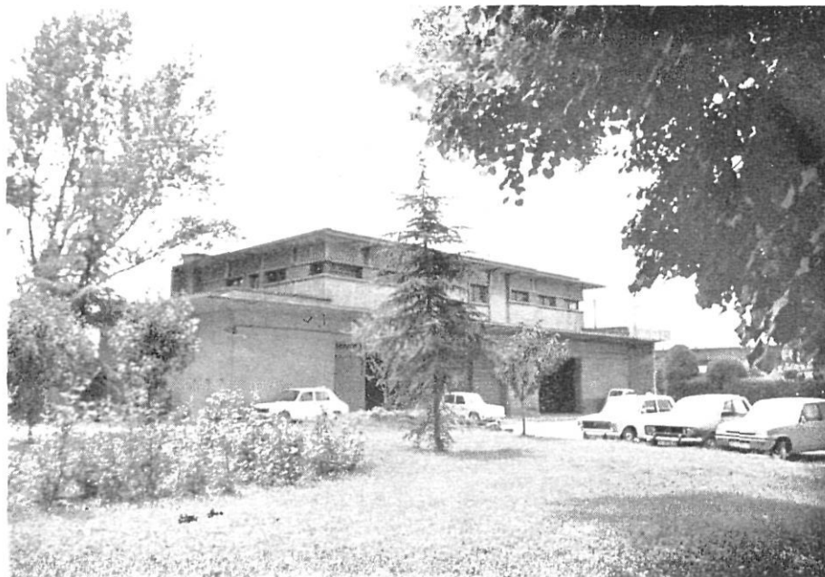
12. — RAFAEL MASO, Magatzem Ensesa, 1932, Carretera Barcelona.
