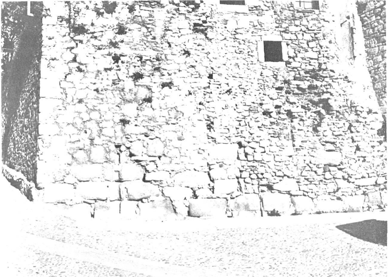
Figura 3. - El tram de muralla prospeccional tal com pot ésser vist avui dia. Són ben visibles les filades i els carreus de pedra sorrenca de la muralla romana tardana.
