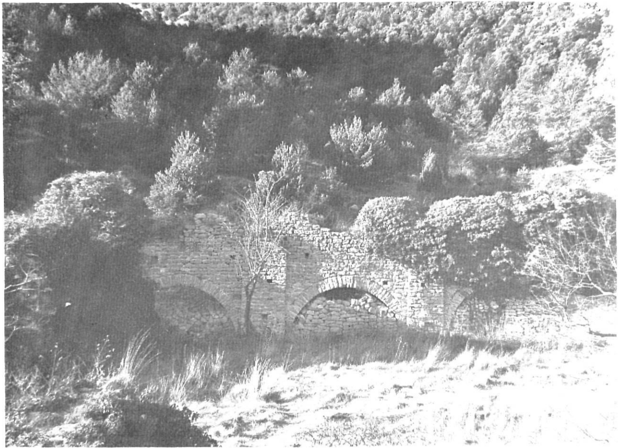
Sant Llorenç de Sous. - Alta Garrotxa. La situació en què es troba actualment el nostre patrimoni arquitectònic reclama amb promptitud una acció responsable per tal d'aturar el seu empobriment i la seva degradació.
