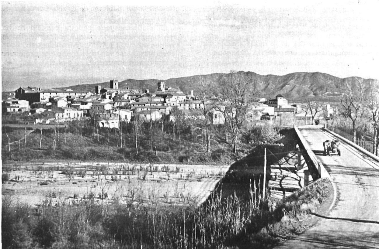
Castelló d'Empúries. - Vista parcial i pont damunt el riu Muga.
