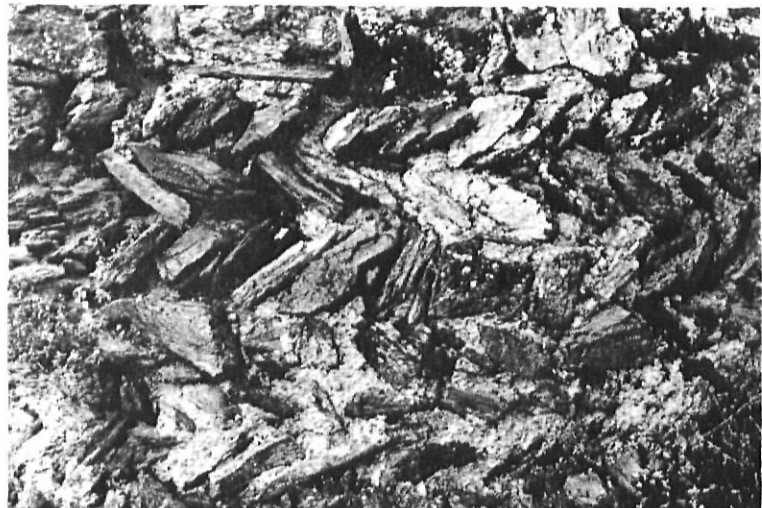
Fig. XLI. - Detall de l'"opus spicatum" de Sant Baldiri.
