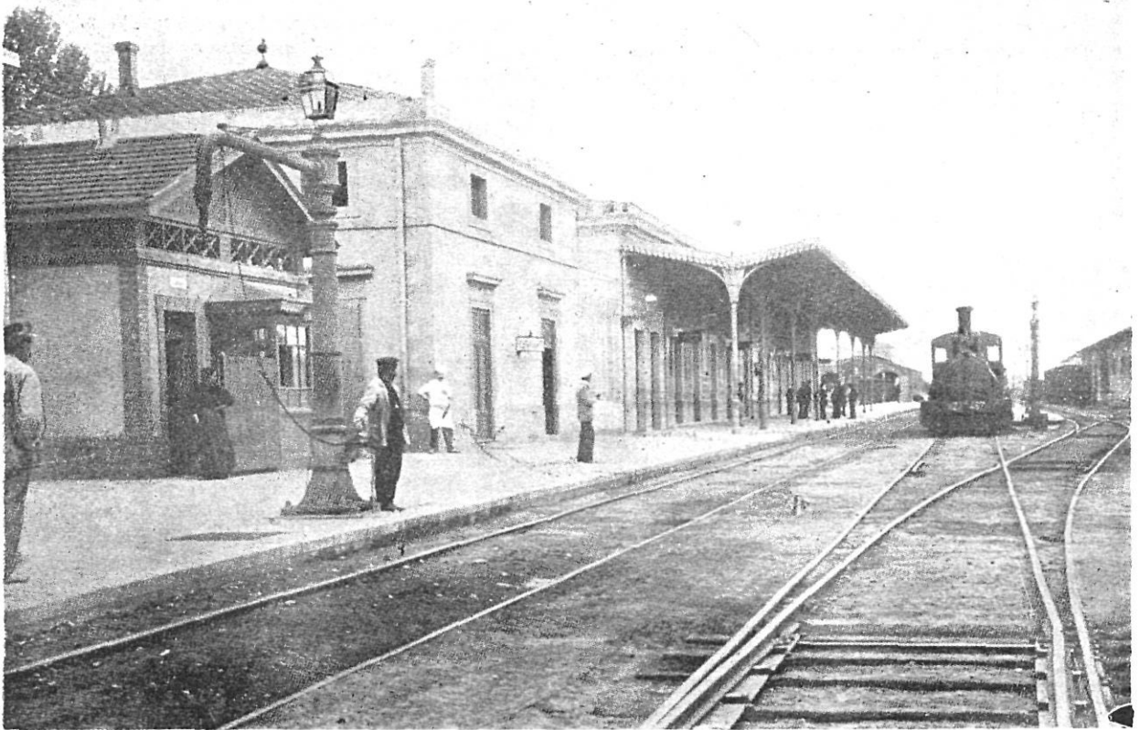
Estación de Gerona, se construyó al prolongarse la línea de Mataró, que fue la primera de España.
