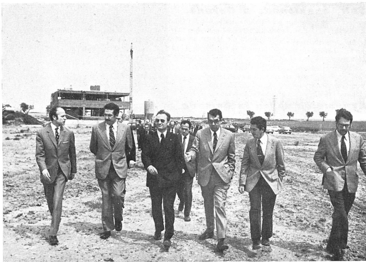
El Sr. Serra Padrosa, en su visita a las obras de la Estación Fitosanitaria de Vilamalla (Foto Sans)
