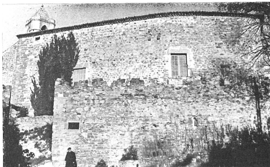
Fachada Oeste del castillo de Púbol
