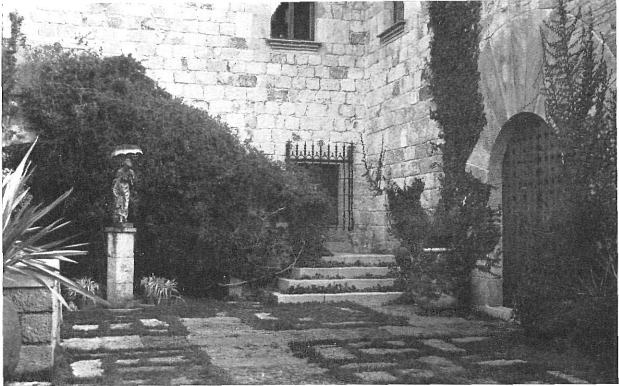
PALS. — Antigua casa Gargola. Jardín de la residencia Pi-Figueras. 1973 (Fot. facilitada por el Ayuntamiento)
