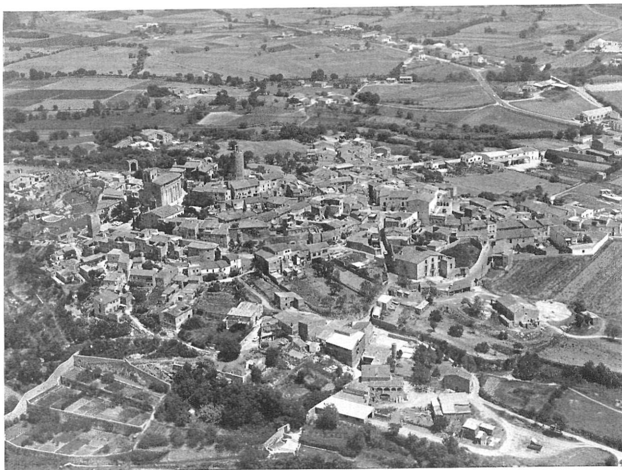
PALS. — Vista aérea de la villa (Foto facilitada por el Ayuntamiento)
