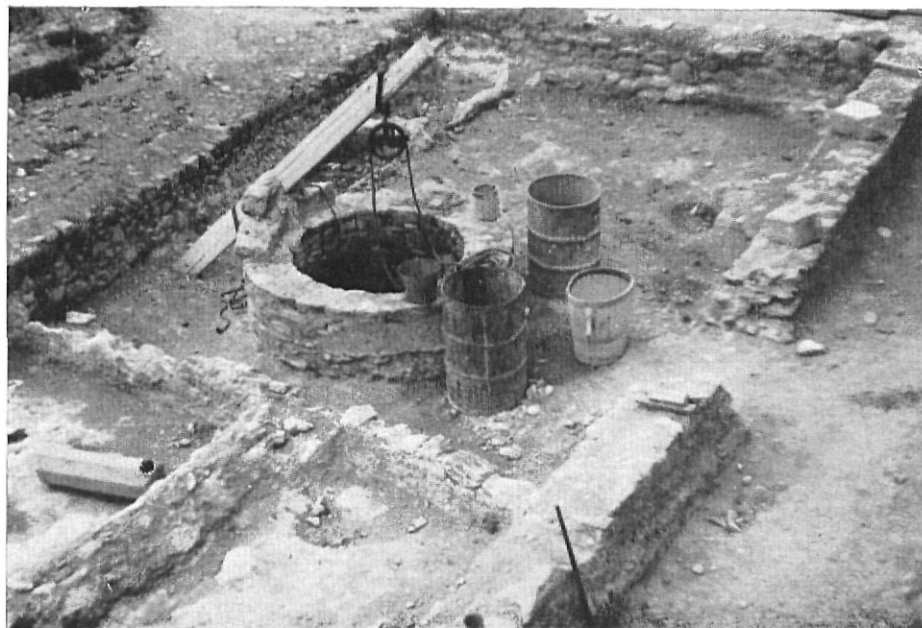
ROSES. — Santa María. Patio del claustro y pozo. Trabajos de 1966. (Foto J. Sanz Roca)
