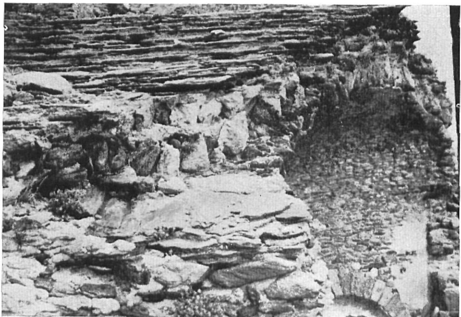
ROSES.— Santa María. Cobertura en pizarra de la nave del crucero. Costado del evangelio. Obras de 1966. (Foto Oliva)
