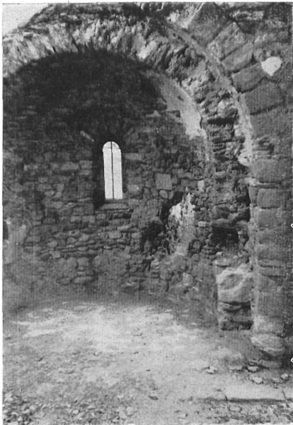
ROSES. — Santa María. Abside lateral del evangelio, con lienzos de muro en "opus spicatum". Restaurado en 1966 (Foto J. Sanz Roca)
