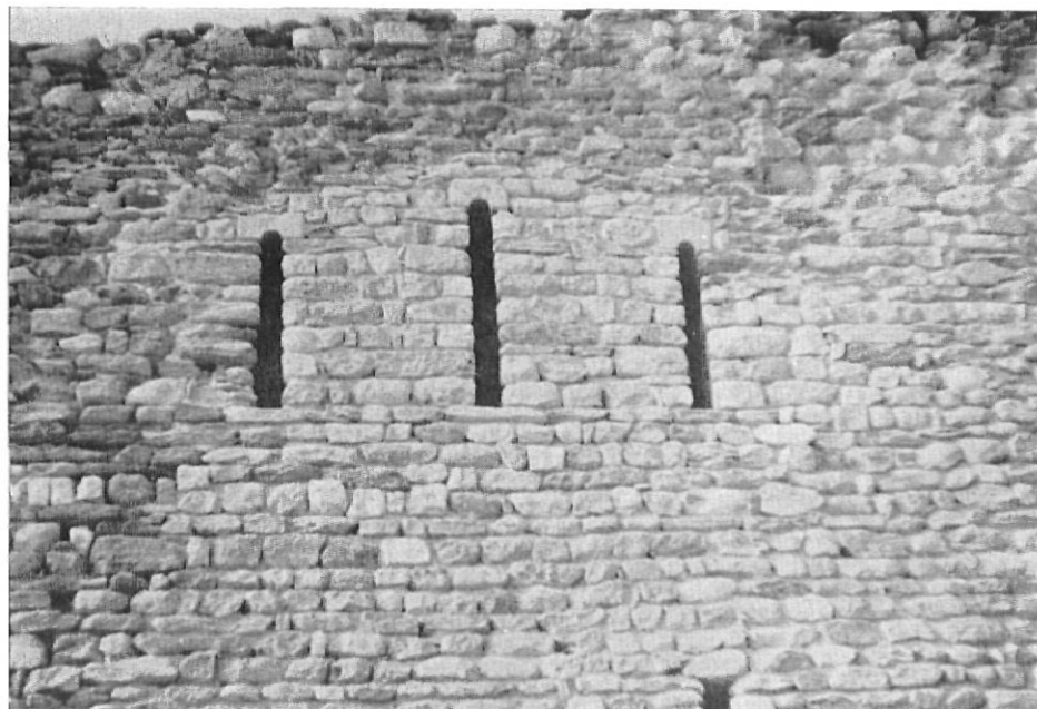
ROSES.— Santa María. Hastial del crucero de la epístola con las tres aberturas en simple derrame y arco monolítico. Restauraciones de 1966. (Foto Sanz Roca)
