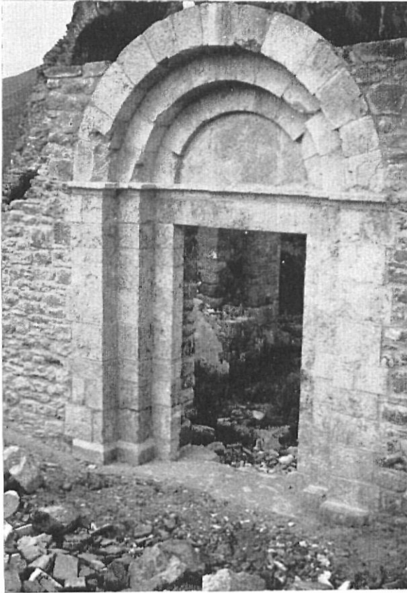
ROSES. — Santa María. Portada principal de fachada, en arcos de degradación. Restaurada por la Diputación Provincial en 1964 (Foto Oliva Prat)
