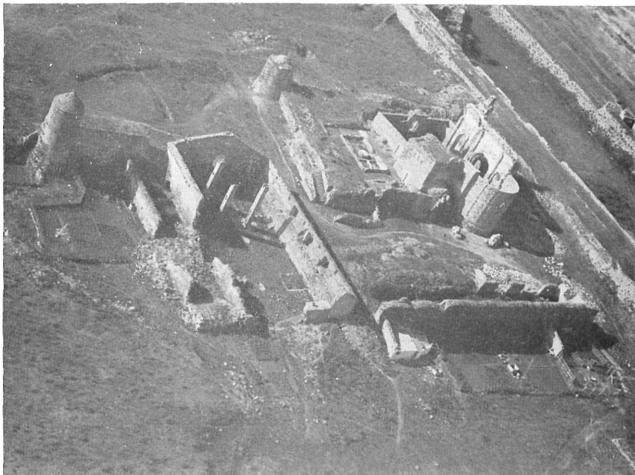
ROSES. — Vista aérea del conjunto de Santa María, en su estado actual antes de la cobertura del ábside. A la izquierda restos del claustro y en torno murallas del primer recinto fortificado del monasterio Torres cilíndricas del siglo XIII-XIV. En primer término la muralla trescentista del segundo recinto. Y una de las casernas que puede albergar el futuro Museo Monográfico y de tema marítimo. Puede observarse el montículo donde se asientan las construcciones, el estado de puesta en valor del monumento y las inmensas posibilidades del conjunto arquitectónico
