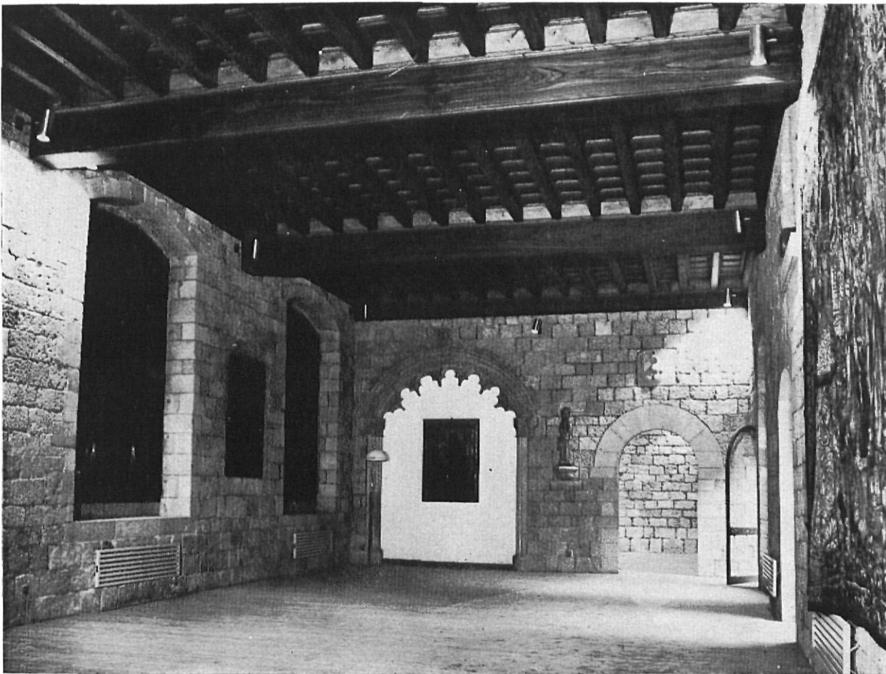
Uno de los salones de este bello edificio, ya restaurado (Foto Martí)
