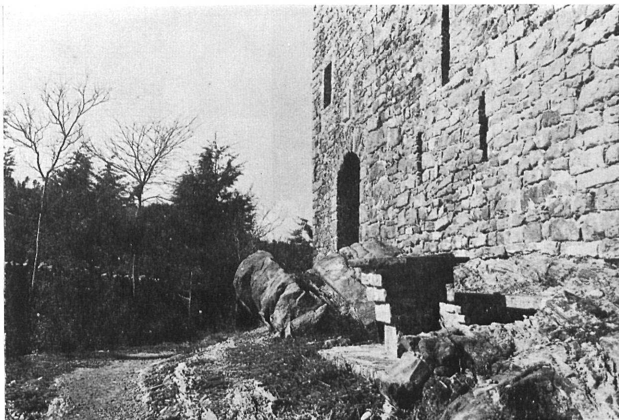
PALMEROLA. — Castillo. Entrada principal al Sur. A la derecha el torreón con sus aspilleras
