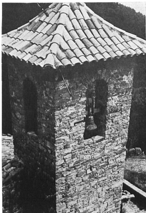
PALMEROLA. — Detalle de la torre de la iglesia a la que falta acabar de descegar los ventanales. La cubierta es obra moderna
