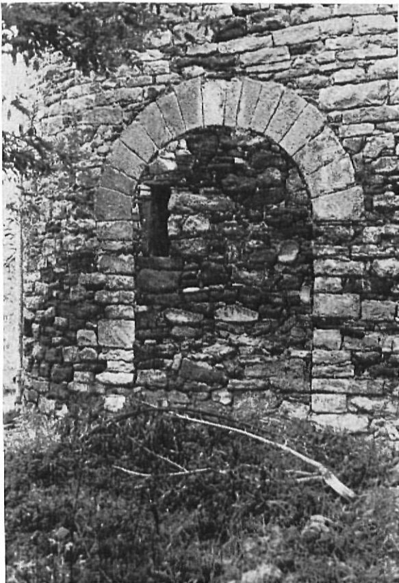
PALMEROLA. — Puerta dovelada que comunicaba con el ábside románico
