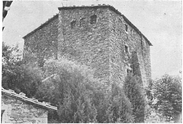
PALMEROLA. — Aspectos de los frentes NO. de las edificaciones.
