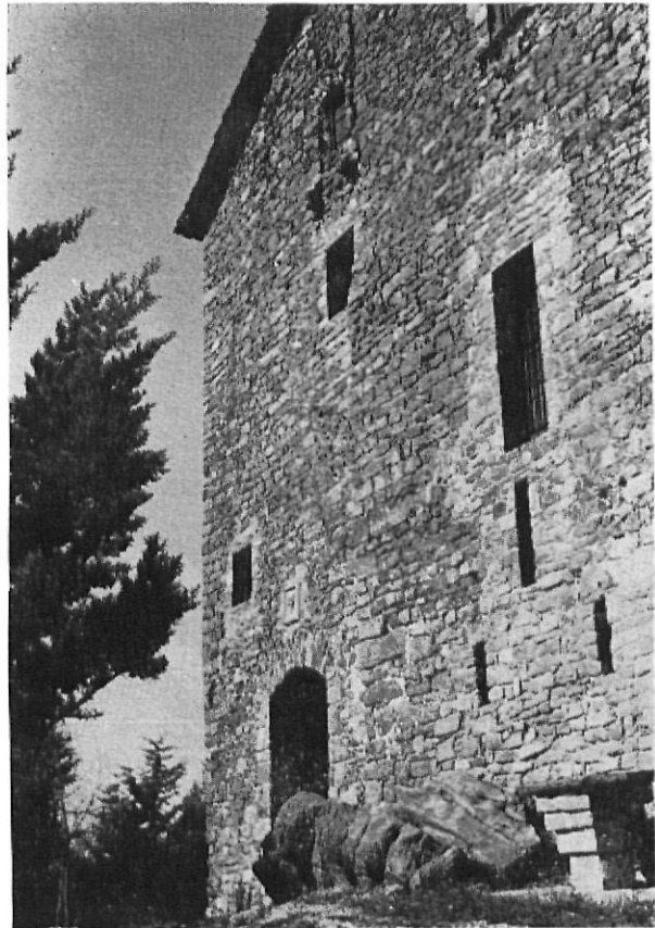
PALMEROLA. — Fachada y esquina SO. Encima la puerta escudo moderno, y en lo alto restos de una barbacana
